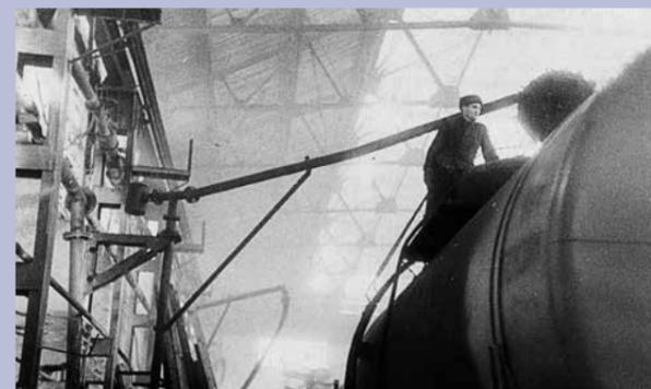
В 1964 г. рационализаторами завода был предложен новый метод окраски и осушки цистерн на основе использования скрытой теплоты парообразования.
