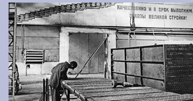
В 1983 г. завод начал поставки оборудования для газопровода «Уренгой-Помары-Ужгород». Для газопровода было поставлено более 150 аппаратов воздушного охлаждения 2АВГ-75С.
