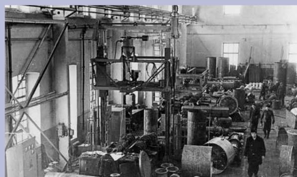
Цех опытных образцов металлоконструкций. Сборка воздухоохладителей.
