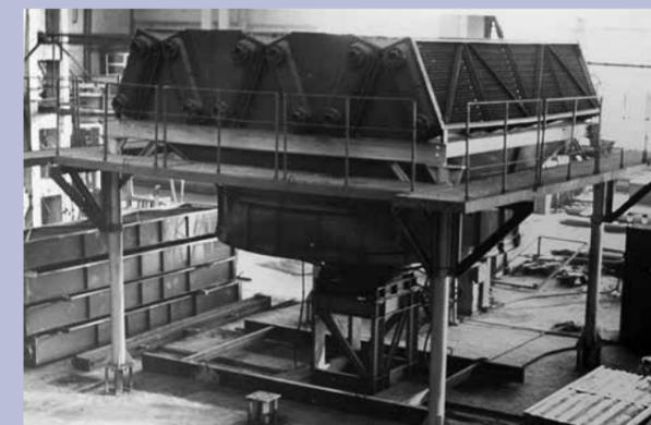
Аппарат воздушного охлаждения АВЗ. Air cooled heat exchangers AVZ.
