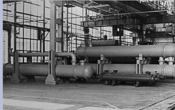
Теплообменники кожухотрубчатые. Shell-and-tube heat exchangers.
